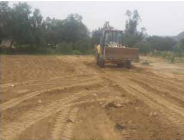
RECUPERACIÓN DE AREA
