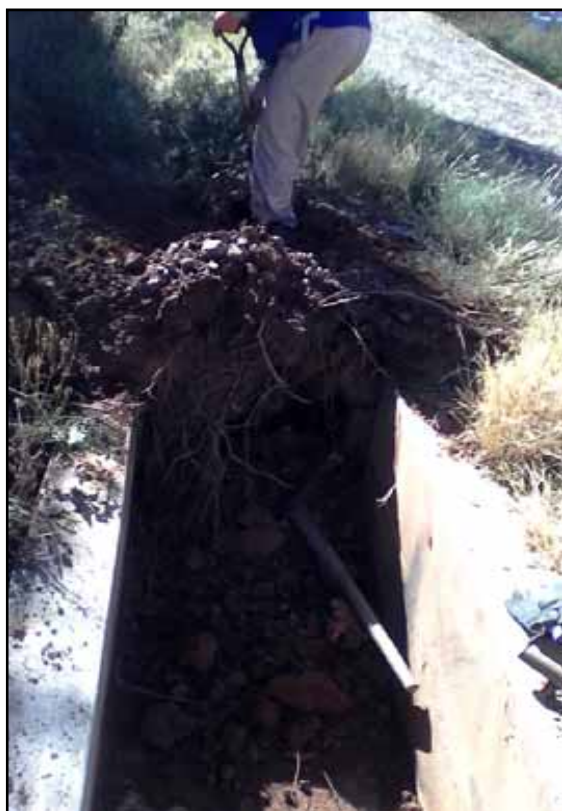
LIMPIEZA DE CANAL D-4
