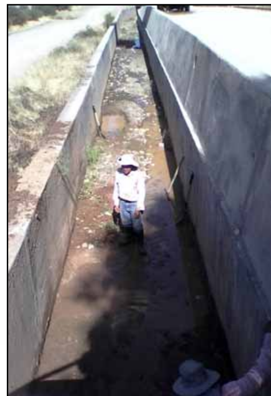
LIMPIEZA DE PUENTE CAJON D-2
