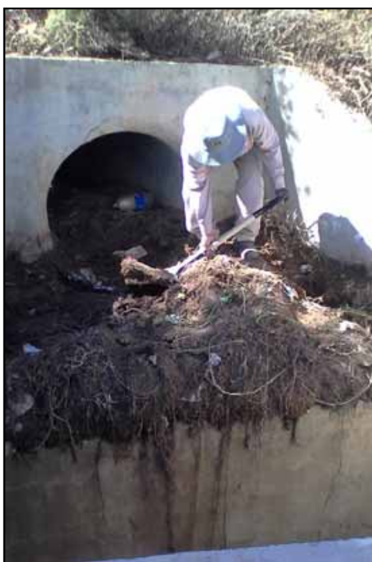
LIMPIEZA DE PUENTE CAJON D-3
